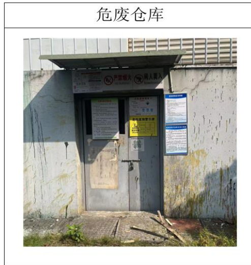
图 3-2 危废仓库现场照片
